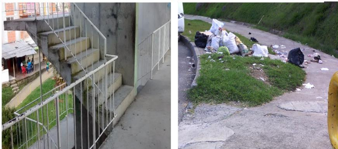
Imagen 3: Áreas comunes de las viviendas
