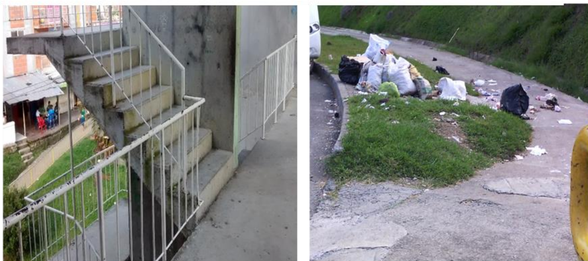
Imagen 3: Áreas comunes de las viviendas
