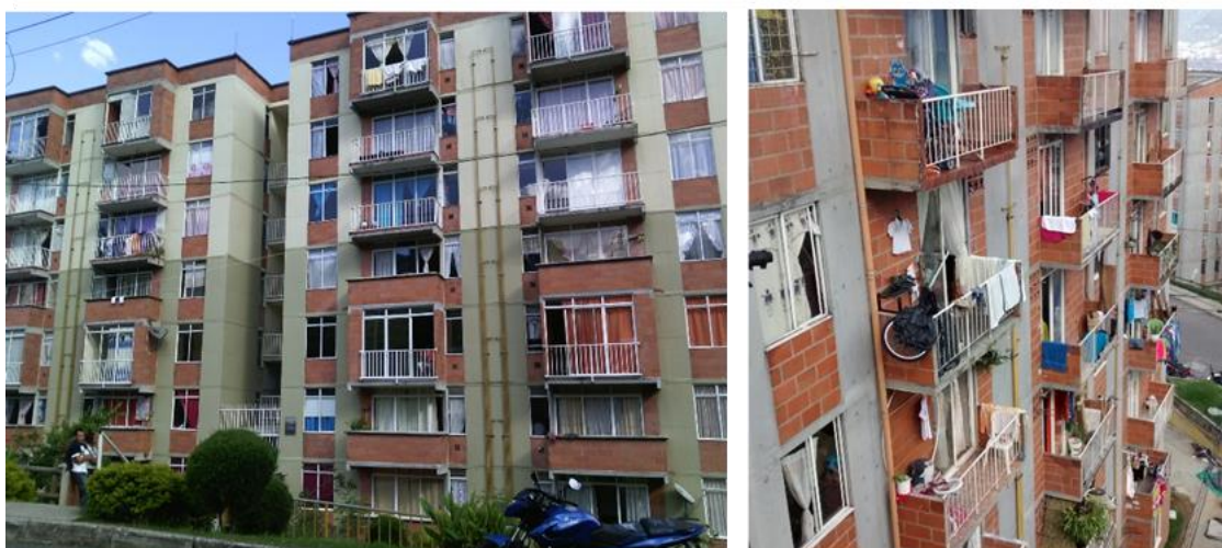
Imagen 2: Fachada de las viviendas
